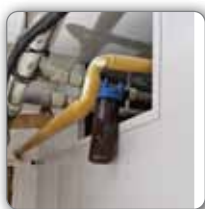
Přizpůsobení rozvodům ve sklepech
